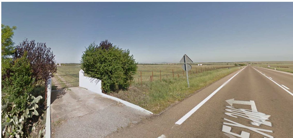
Fotografía 1. Acceso del vial de entrada a la zona de implantación. Y Carretera EX-206. Al fondo zona de implantación.
