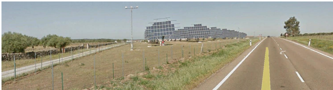
Figura 24. Instalaciones pertenecientes a otro Parque solar próximo a las instalaciones
